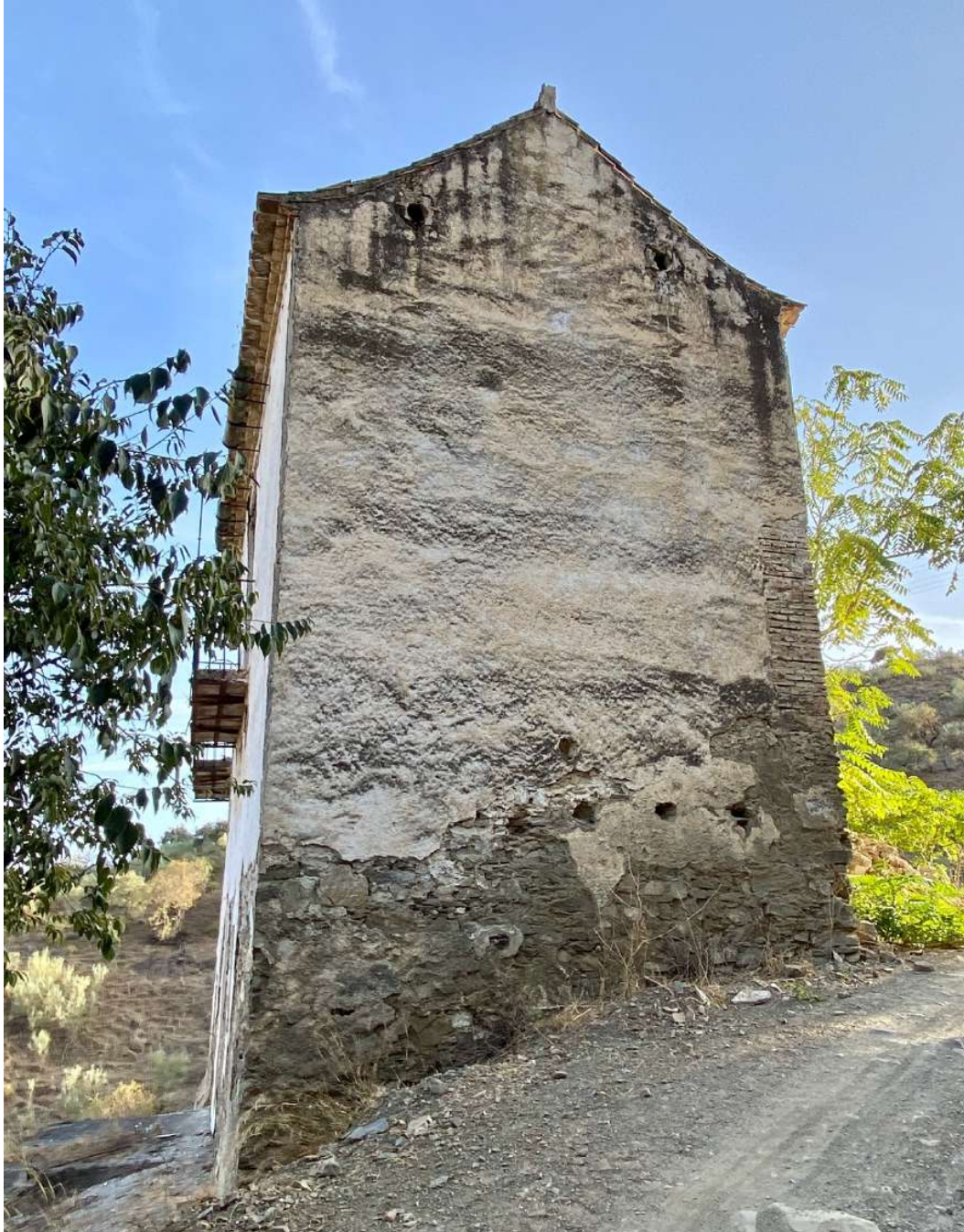
Lámina 30. Lagar de Cerillar o Maroto. Construcción tradicional del siglo XIX, cuya estructura se erige con mampostería con esquinas de ladrillo y cubierta inclinada de teja con lozano.
