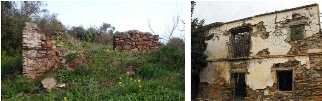
Láminas 23 y 24. Los vestigios de arquitectura tradicional en los Montes de Málaga. A la izquierda, restos de vivienda de mampostería en el Puerto de la Bolina; a la derecha, lagar de San Joaquín en Totalán. Fuente: Jesús Palenzuela Illán
