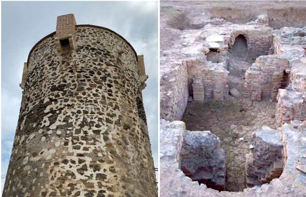
Láminas 28 y 29. Empleo de ladrillo en elementos de diversa época: ladroneras de la Torre de Benagalbón (izquierda) y hipocausto de las termas de la Villa Romana (derecha).
