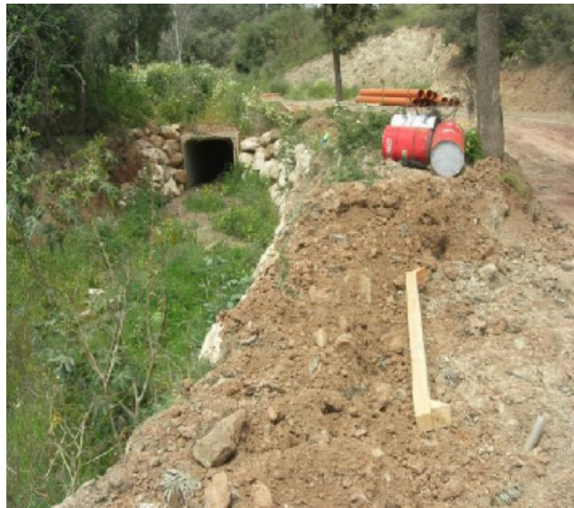
Fotografía nº 1: Cajón de 2x2 metros. Vista desde aguas abajo. Puede verse el carril de tierras a la derecha antes de la urbanización del vial. Año 2007.
