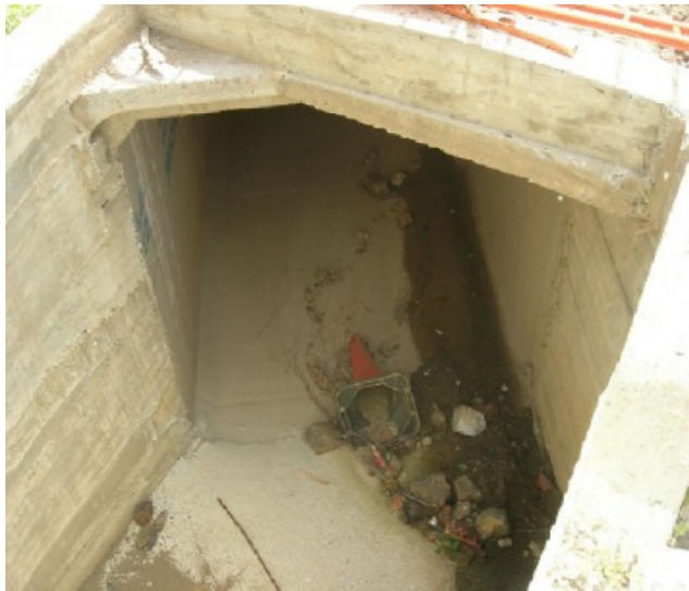
Fotografía nº 3: Cajón de 2x2 metros. Vista desde aguas arriba, arqueta donde termina el cajón. Año 2007.
