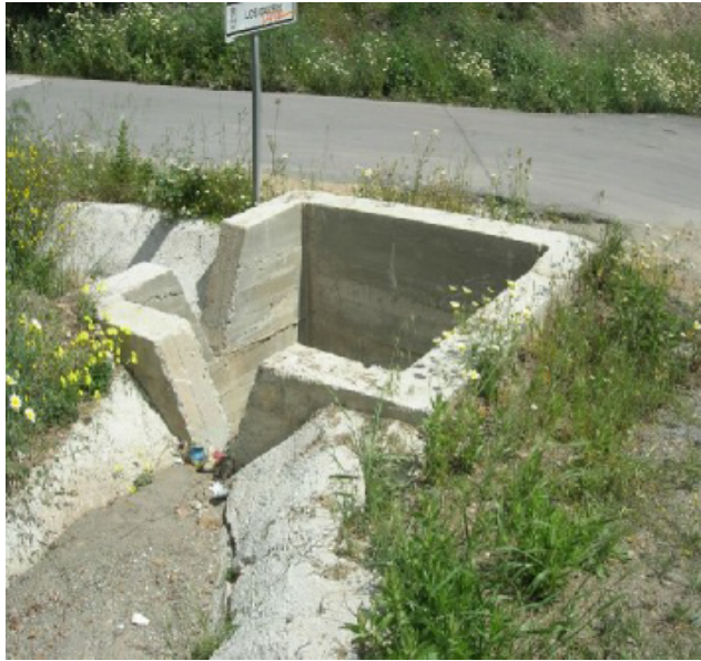
Fotografía nº 3: Cajón de 2x2 metros. Vista desde aguas arriba, arqueta donde termina el cajón. Puede verse el vial de calle Luxemburgo antes de urbanización sin aceras. A la obra de drenaje transversal le llegaban dos cunetas, unas al norte procedente de calle Los Caleros y otra del noroeste procedente de calle Luxemburgo. Año 2007.
