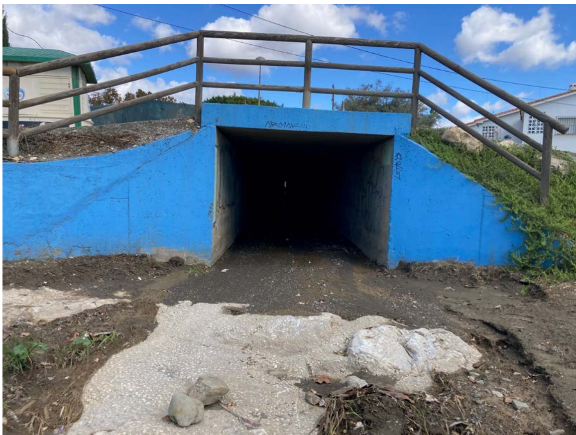
OBRA DE FÁBRICA DE 2,5x2,0 m 2 BAJO LA AVDA. DE MÁLAGA
