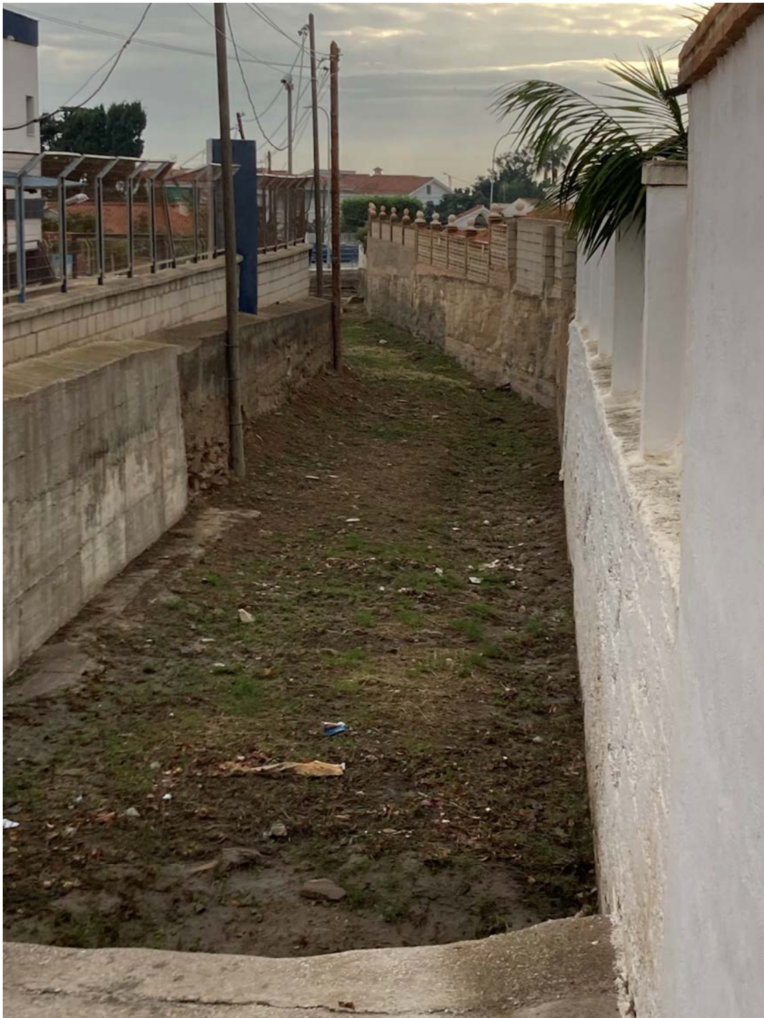
CANALIZACIÓN RECTANGULAR ABIERTA
