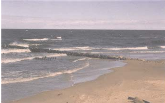
figura 3 Ejemplo de espigón construido con dos pilas de madera (península de Hel, Mar del Norte)
